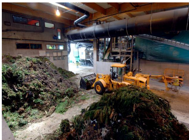
Préparation des bio-déchets
